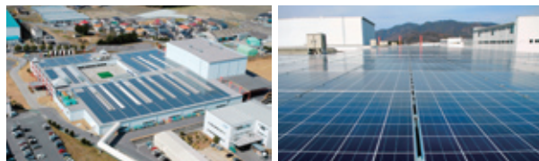
ベネッセ・ロジスティクス・センターの太陽光電池パネル
