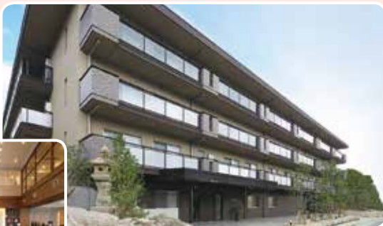
住宅型有料老人ホーム「メディカルホームグランダ高宮」 〈定員67名／居室数60室（全室個室）〉
